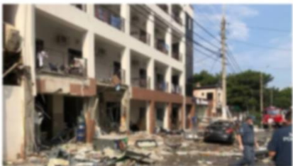
Причиной взрыва в гостинице «Адыгея» в Геленджике стала утечка на магистральном газопроводе, проложенном в непосредственной близости от здания.
